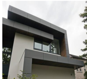
Şekil 4: Kompozit Sistem Detayı; Private Residence, Toronto (Canada) [2]
