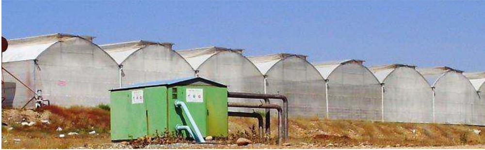
Figür 6. Petrolden ayrıştırılmış sıcak suyun ısıtmasına yarayan eşanjör
