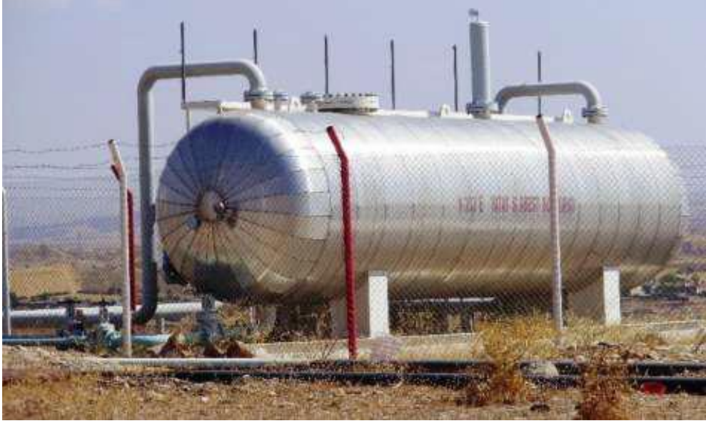
Figür 5. Su ve ham petrolün birbirinden ayrıldığı serbest su ayırıcı tankı
