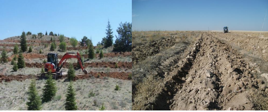
Şekil 5. İç Anadolu’da eğimli ve düz arazide alt ve üst-toprak işleme
