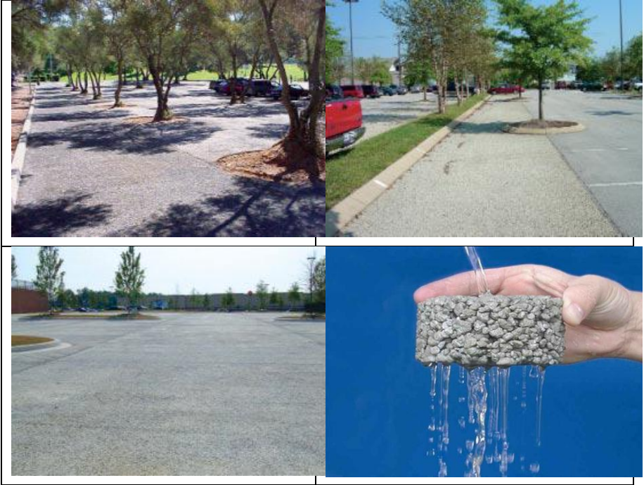
Şekil 1. Geçirimli beton için örnek uygulamalar (Tennis et al., 2004)
