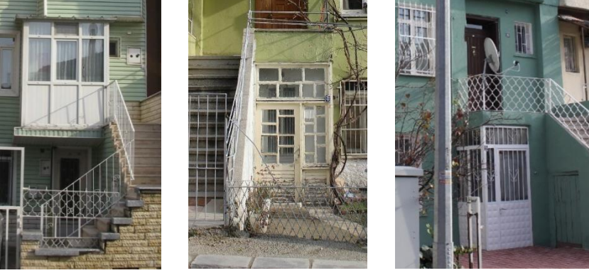
Resim 12. Yapılarda elemanların değişimine örnekler
