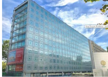
Fotoğraf 4, 5, 6: Arap Dünyası Enstitüsü Binası, Mimar, Jean Nouvel'e
