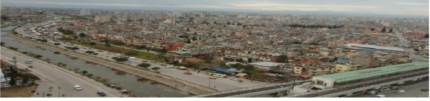
Şekil 19: Adana 2000 Evler Afet Riskli Alan Dönüşüm Projesi Alanı Fotoğrafı.
