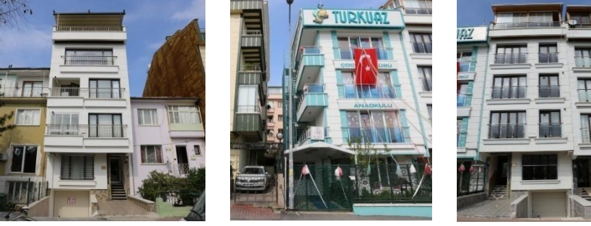
Resim 17. Yıkılan konutların yerine yapılan apartmanlar
