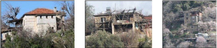
Resim 7. Asmaca Köyü (solda), Bayır Köyü (ortada) ve Bayırkozağacı Köyü'nde (sağda) eklenmiş briket çıkma, betonarme teras ve tuğla eklenti yapı görünümü.
