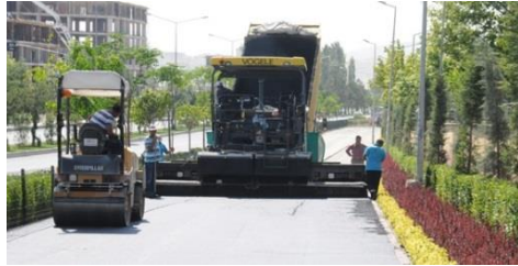
Şekil 1. Niğde İli Atatürk Bulvarı Bisiklet Yolu Yapım Aşaması
