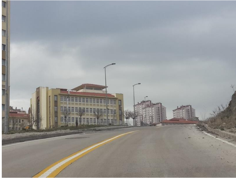
Foto 3: Yapracık Mahallesi'ndeki Şehit Kara Pilot Tahsin Barutçu MTAL ve Çevresi Yüksek Eğimli Bir Sahada İnşa edilmiştir.
