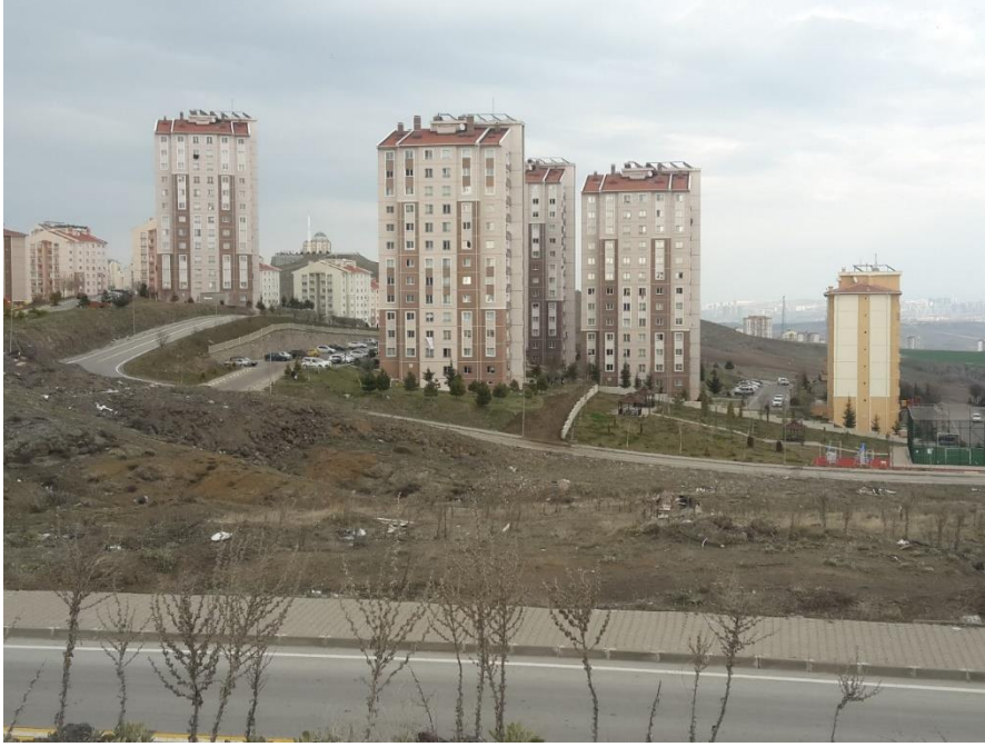
Foto 4: Yapracık Mahallesinde Yüksek Eğimli Araziler Üzerinde Yapılaşma Gerçekleşmektedir.
