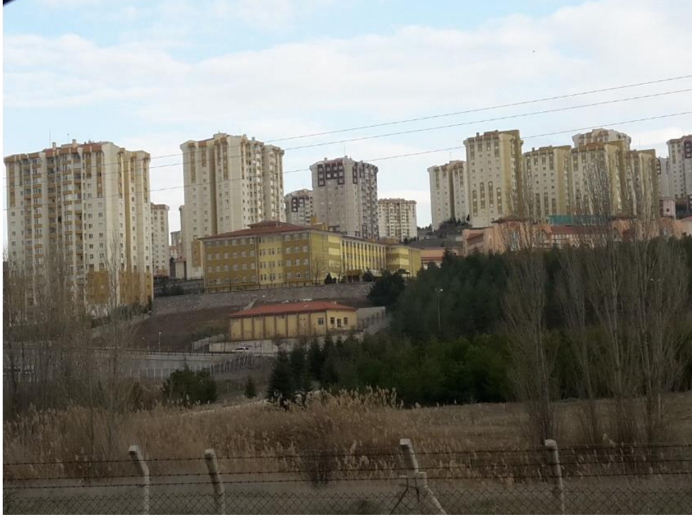
Foto 5: Aşağı Yurtçu Mahallesiindeki Faruk Nafiz Çamlıbel Anadolu Lisesi Kuzey Yönüne Bakan Arazide İnşa Edilmiştir. Bu yüzden Binanın Girişi Batı Yönüne Bakacak Şekilde İnşa Edilmiştir.
