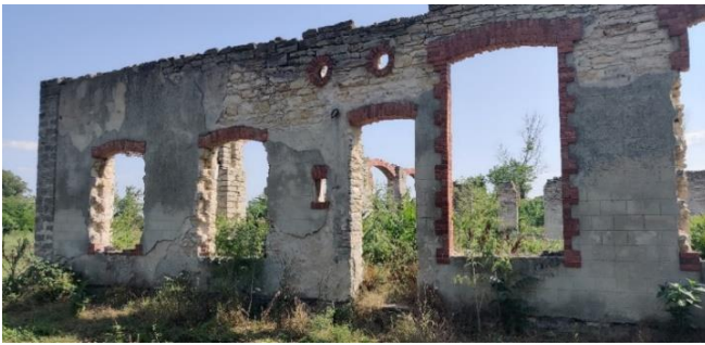
Şekil 3. Cephelerdeki niteliksiz onarımlar (2021)
