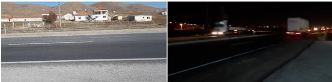
Şekil 1. Aksaray-Ankara D750 Devlet Karayolu (ölçüm yapılan kesit)
