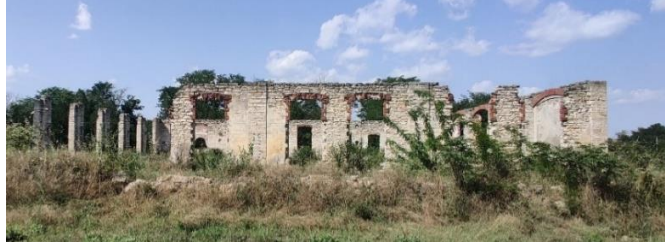
Şekil 6. Yapının güney duvarına bakış (2021)
