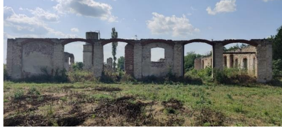
Şekil 16. Doğu cephesindeki açıklıkların muhdes duvarlarla örülmesi (2021)
