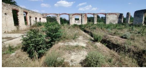
Şekil 15. Yapının iç mekânından tamir çukurları (2021)
