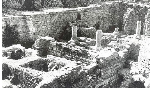
Görsel 6. Son dönemlerde yıkılmış olan hamamın kuzeybatıdan görünümü. Sarnıç cephesi arka plandadır. Önde ise merkezi hamam odaları bulunmaktadır.
