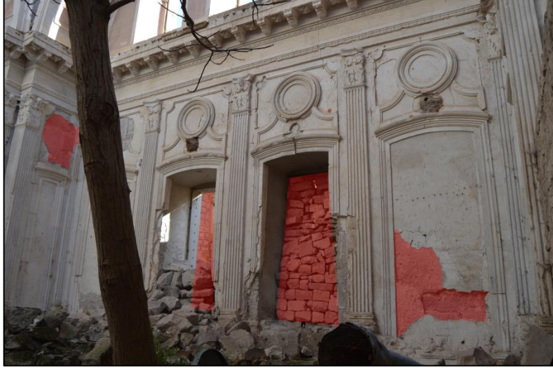
Şekil 31: Naos güney duvarındaki bozulmalar (Orijinal,2019)
