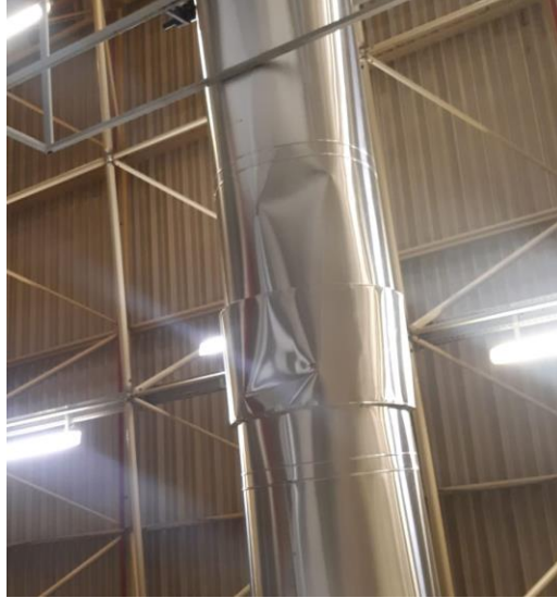
Şekil 5. Egzoz sisteminde oluşan deformeler
