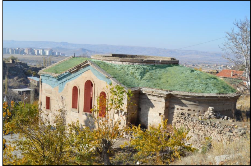
Şekil 26: Güney cephe hasarları (Orijinal, 2019)
