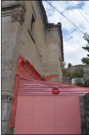
Şekil 25: Güney cephe yıkılan teras izleri (Orijinal, 2019)
