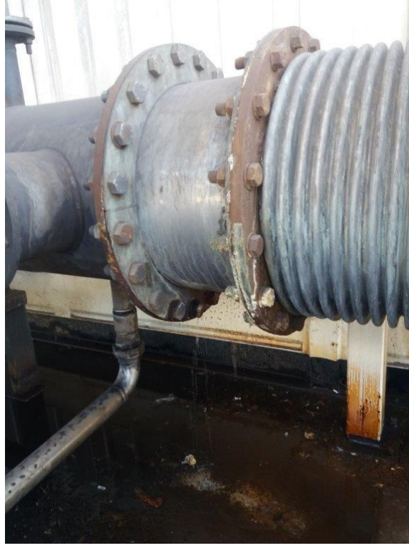
Şekil 4. Egzoz sisteminde oluşan deformeler
