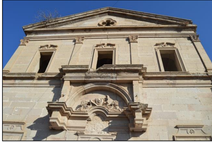
Şekil 16: Kilise Batı Cephesi Galeri Katı (Orijinal, 2019)
