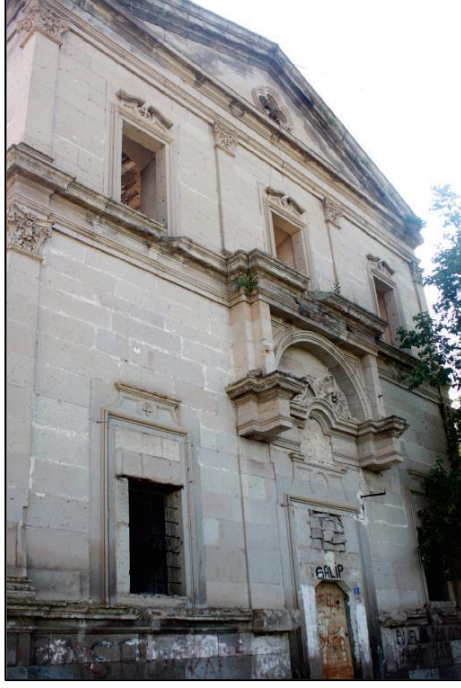
Şekil 15: Kilise Batı cephesi (Hançer, 2016)
