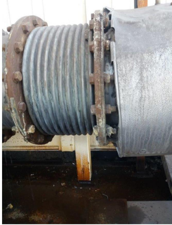
Şekil 6. Egzoz sisteminde oluşan deformeler
