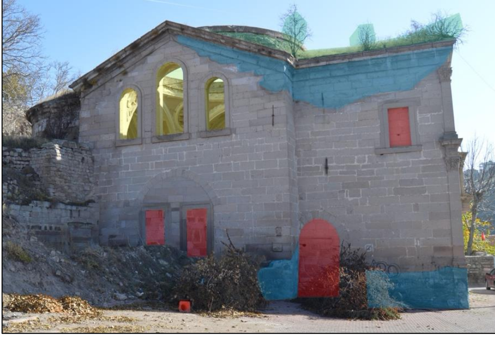
Şekil 24: Kuzey cephe hasarları (Orijinal, 2019)
