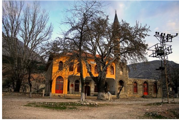
Şekil 5. Alaaddin Camii Kuzey Cephesi (2006)
