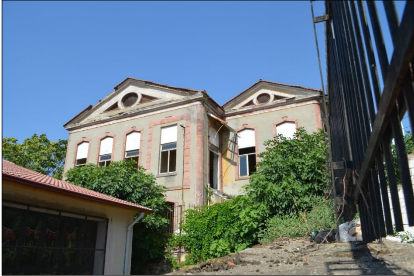
Şekil 12. Ayayani Rum Kız Okulu Batı Cephesi (Aybüke Ersoy arşivi, 2019)
