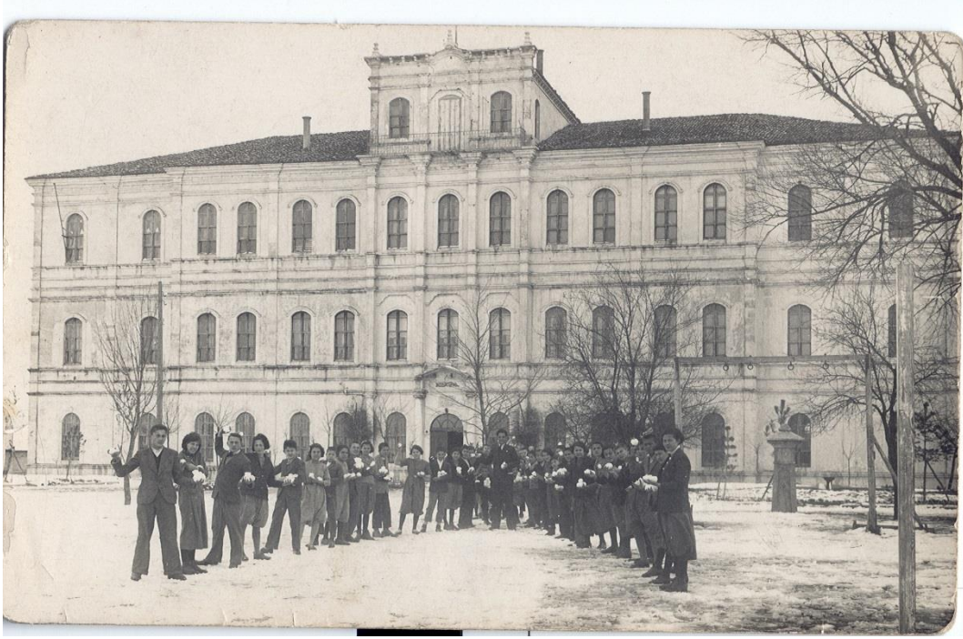
Foto 6: Bolu Sultanisi Ön Cephe
