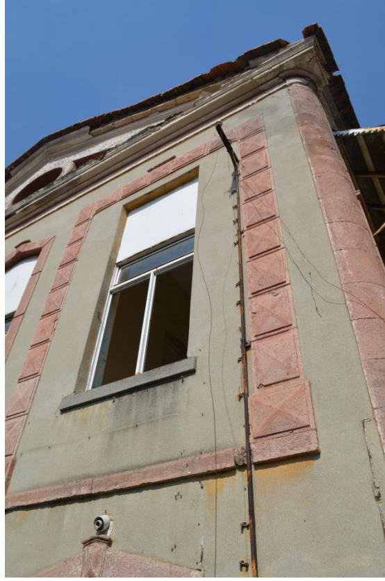
Şekil 11. Ayayani Rum Kız Okulu Batı Cephesi daraltılan pencere (Aybüke Ersoy arşivi, 2019)
