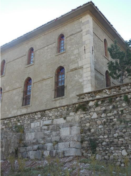
Şekil 16 - 17. Yapının güney cephesindeki devşirme malzeme kullanımları
