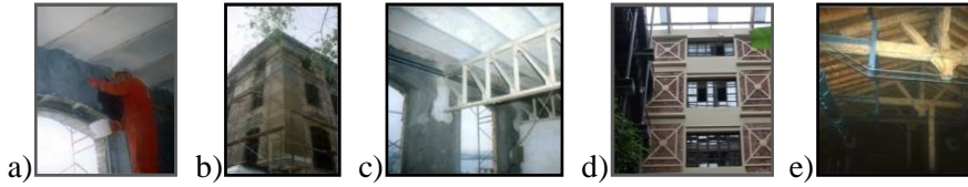
Şekil 11: a-b-c) Epoksi ile yapılan güçlendirmeler d) G-H blok arasında açılan avluda metal çaprazlarla yapılan güçlendirmeler,
