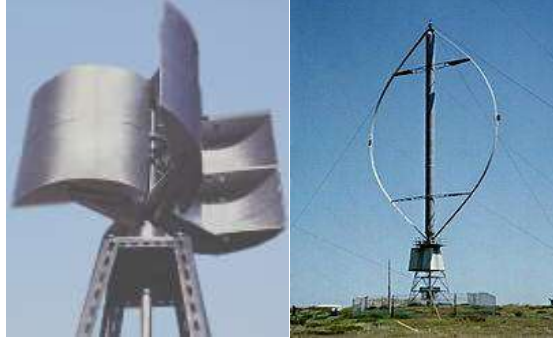
Şekil 4. Dikey eksenli rüzgâr türbinleri. (a) Savonious RT (b) Darrieus RT (Şen, 2011)
