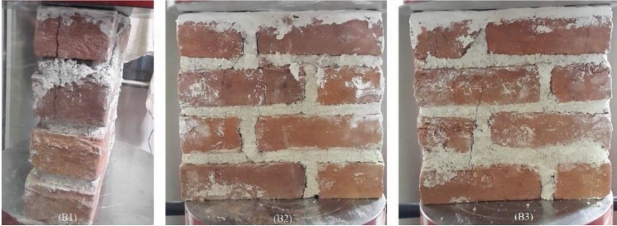
Şekil 5. Tek eksenli basınç deneyi sonucunda 4 sıra tuğla duvar numunelerinde oluşan çatlaklar.
