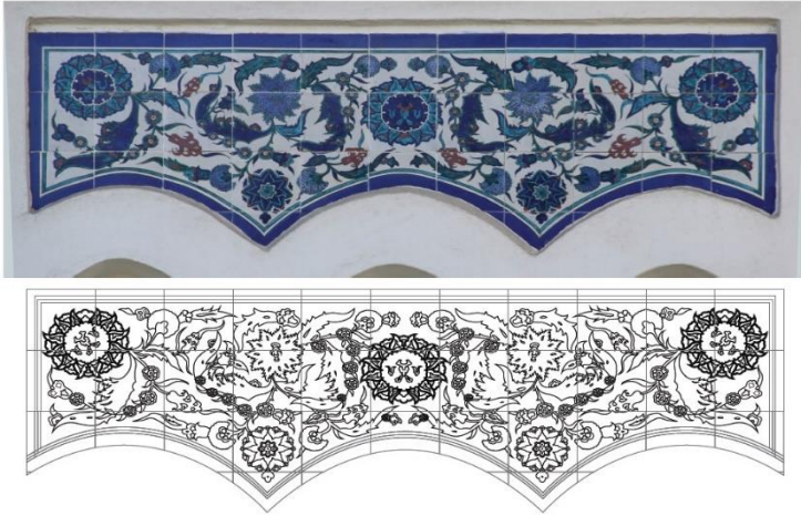
Şekil 4: Devlet Tiyatrosu Binası kuzeydoğu cephesi çini panoları (Serap Işıkkhan Arşivi 2019)
