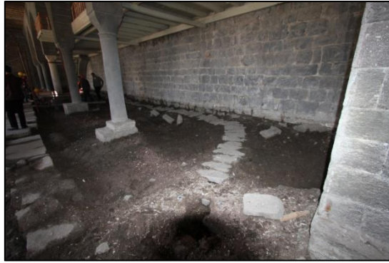
Şekil 4. Su kanalının görünüşü
