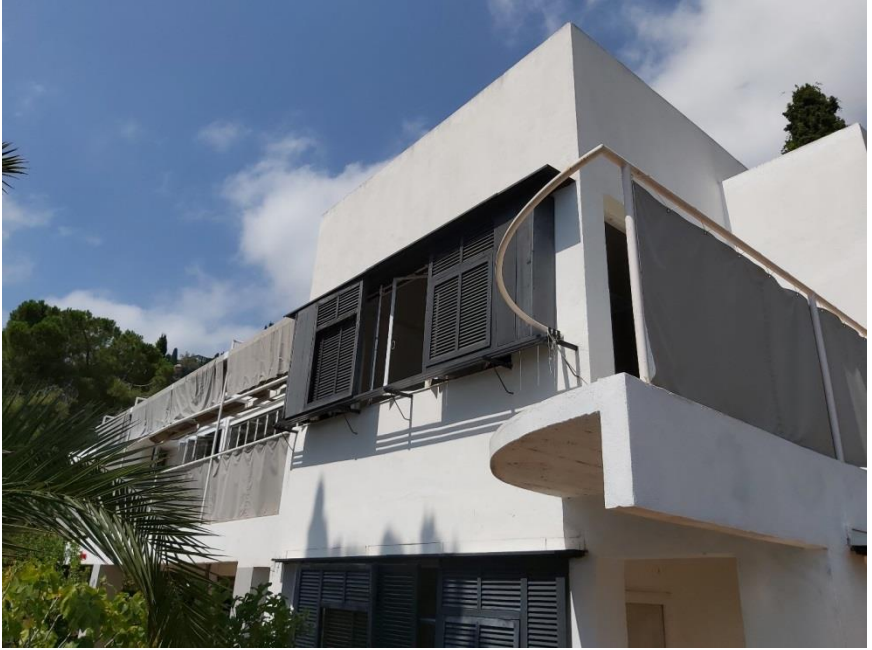
Resim 2: E.1027 evi dış görünüş
