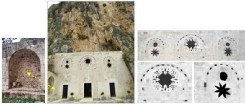
Foto 1. St. Pierre Kilisesinin cephesi ve tepe pencereleri
