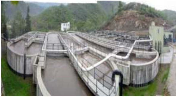
Şekil 1. Atıksu Arıtma Tesisi
